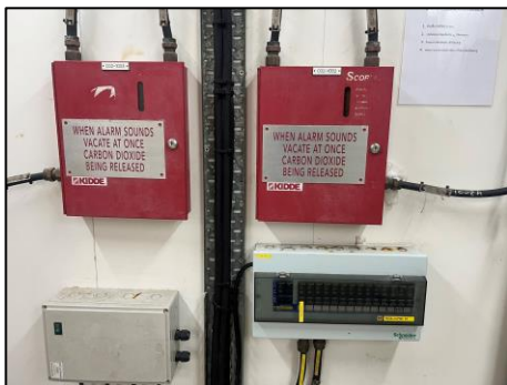
รูปที่ 2-14 อุปกรณ์แจ้งเตือน และอุปกรณ์ดับเพลิง บริเวณท่าเทียบเรือกลางทะเล
