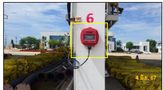
รูปที่ 2-20 อุปกรณ์แจ้งเตือน และอุปกรณ์ดับเพลิง บริเวณสถานีไฟฟ้าย่อย 2
