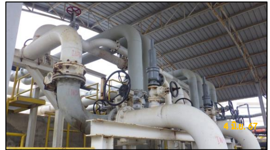
รูปที่ 2-2 วาล์วของระบบท่อส่งน้ำมัน (Pump PAD No.3)
