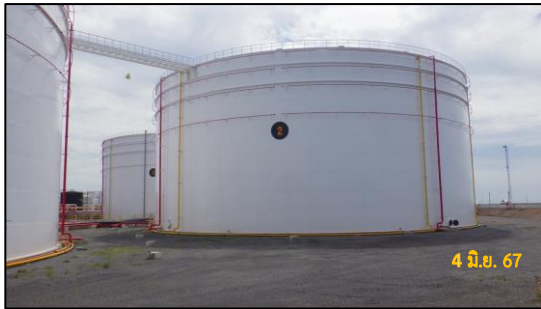
รูปที่ 2-1 ถัง Floating roof
