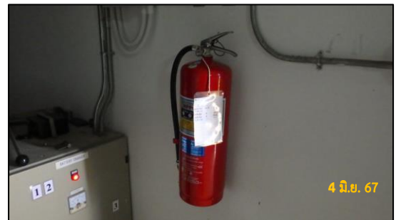
รูปที่ 2-20 อุปกรณ์แจ้งเตือน และอุปกรณ์ดับเพลิง บริเวณสถานีไฟฟ้าย่อย 2
