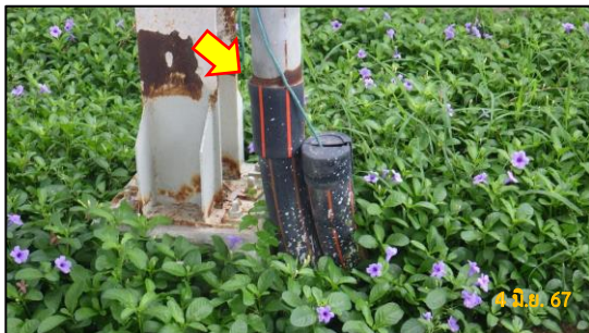
รูปที่ 2-24 ระบบสายดินบริเวณสถานีไฟฟ้าย่อย (Grounding System)
