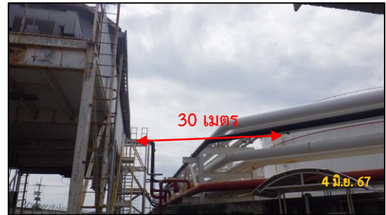
รูปที่ 2-16 สถานีไฟฟ้าย่อยอาคารที่ 2 และระยะห่างจากถังเก็บน้ำมัน
