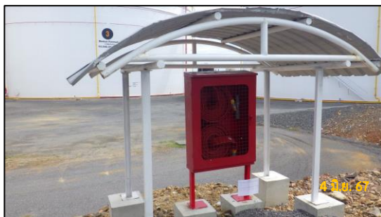
รูปที่ 2-21 อุปกรณ์แจ้งเตือน และอุปกรณ์ดับเพลิง บริเวณโดยรอบสถานีไฟฟ้าย่อย และพื้นที่โดยรอบโครงการ
